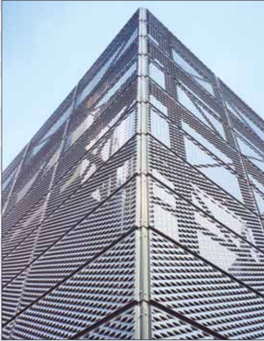
AMBASCIATA - DL 110 x DC 40 (52) - av 24 x sp 2 mm Stahlblech, feuerverzinkt
