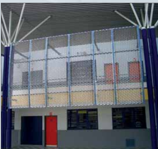
COLISEUM - DL 200 x DC 75 (80) - av 24 x sp 2 mm Aluminium
