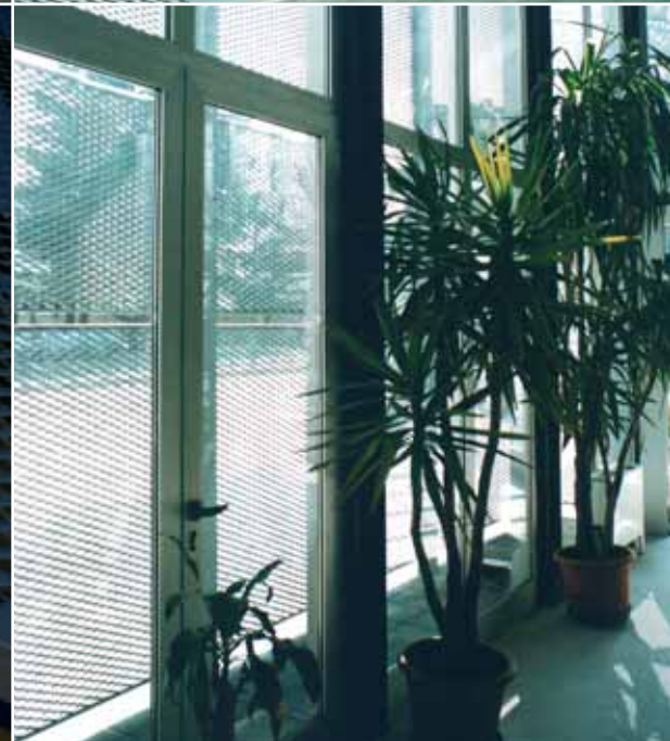
GATE - DL 76 x DC 31 (35) - av 11 x sp 2 mm Stahlblech, feuerverzinkt
