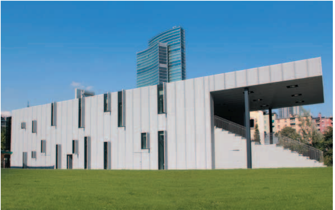
KUNST-INKUBATOR - MAILAND (Italien) Projekt: Stefano Boeri, Gianandrea Barreca, Giovanni La Varra Verkleidung in Streckmetall: DELTASYSTEM INTERNATIONAL Foto: Archiv Longhigroup
