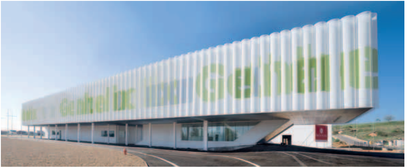
GH GENHELIX BIOPHARMACEUTICAL FACILITIES – LEÓN (Spanien) Projekt: Esaú Acosta, Mauro Gil-Fournier, Miguel Jaenicke, estudiosic Foto: Esaú Acosta
