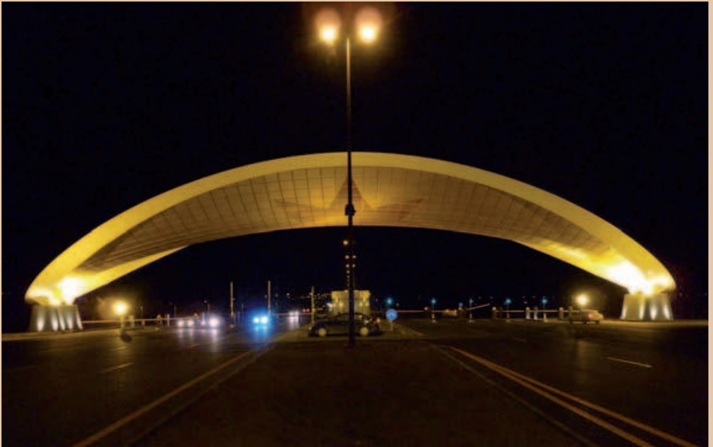
EINGANGSBEREICH INTERNATIONAL AIRPORT HEYDAR ALIYEV – BAKU (Aserbaidshan) Projekt: ARUP - Arch. FREAD DEACON Projekt Metallstrukturen: WAAGNER BIRO (Stahlbau) Verkleidung in Streckmetall: METALLTECH Foto: © Arup
