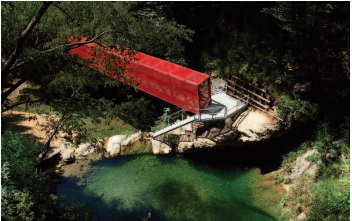
STEG ÜBER DEN BACH IM "PARCO DEL GIGANTE" - BERGAMO (Italien) Projekt: Arch. Gualtiero Oberti Foto: Arch. Gualtiero Oberti
