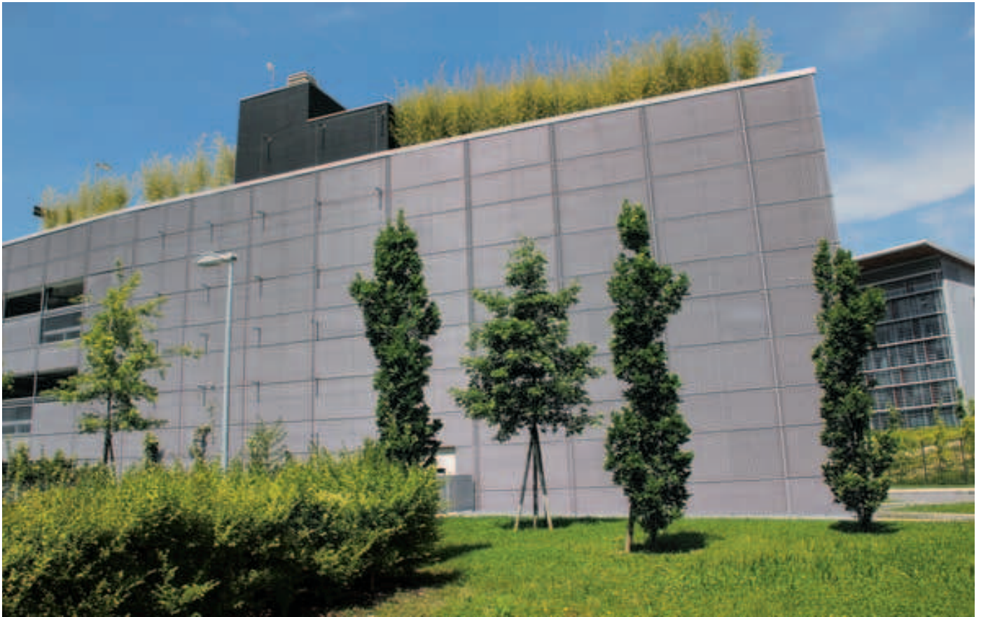
NEUES KRANKENHAUS PAPA GIOVANNI XXIII - BERGAMO (Italien) Projekt: Studio Arch. TRAVERSI+TRAVERSI Verkleidung in Streckmetall: METALLTECH Foto: Archiv Longhigroup
